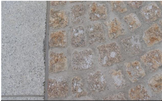
Als Fugenfüller des Naturstein-Kleinpflasters wurde der Sakret Steinverguss Rusitc ZPF grau eingesetzt. | Foto: Michael Bader, Leipzig
