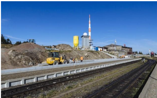
Kurze Bauzeit, extreme Wetterbedingungen, logistische Herausforderungen – das Sanierungsprojekt hatte es in sich. | Foto: Michael Bader, Leipzig
