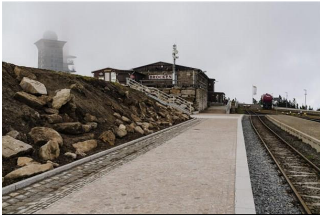
Der sanierte Bahnsteig der Station Brocken. | Foto: Michael Bader, Leipzig
